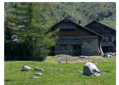
Panneaux solaires en façade
