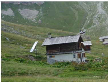
Panneau solaire éloigné du chalet
