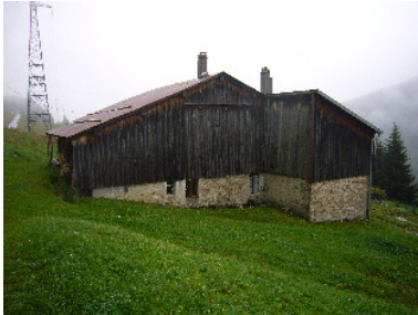
Pylône près d'un chalet ayant un impact sur le paysage
