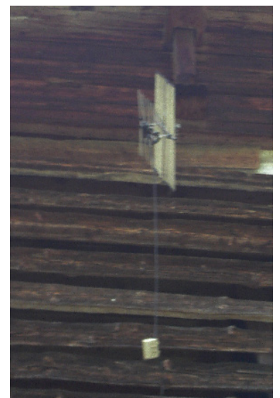
Antenne râteau en pignon de façade
