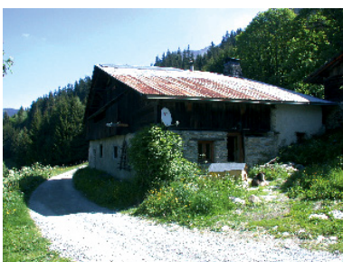
Parabole en façade
