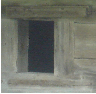
Une simple ouverture dans un mur en bois
