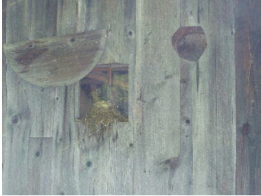
Ouverture fermée par une simple planche
