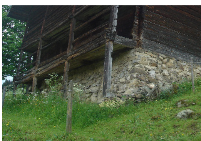
Clôture piquets et fil de fer
