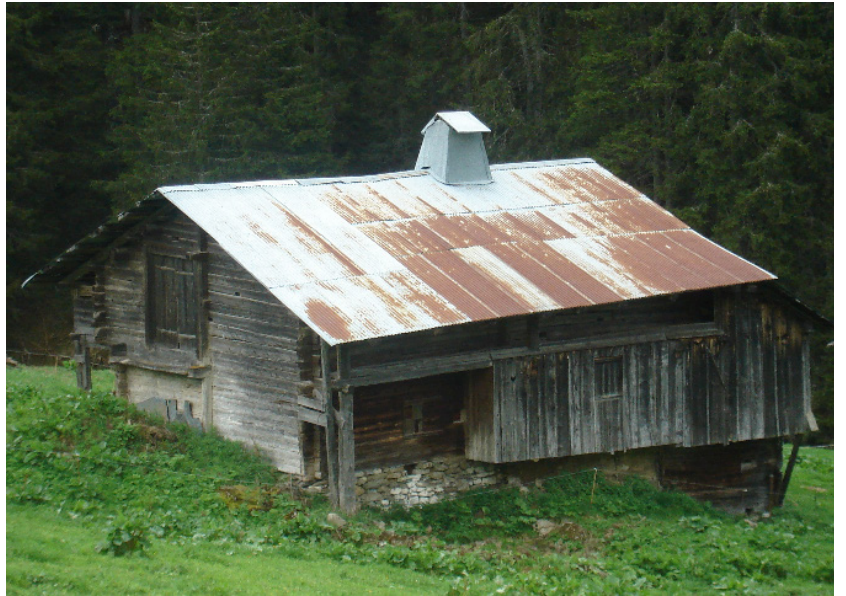
Façades côté fenil et fosse à purin
