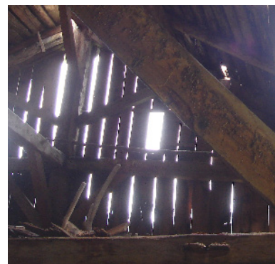
Bardage non jointif permettant des ouvertures
