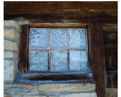
Encadrement en bois massif au nu extérieur du mur de façade
