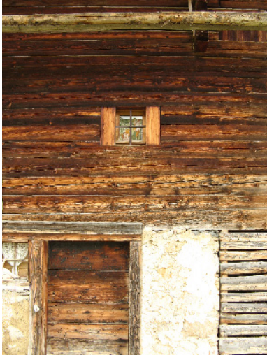
Porte et fenêtre
