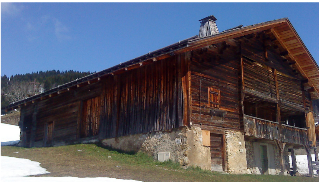
Les différentes parties du bâtiment
