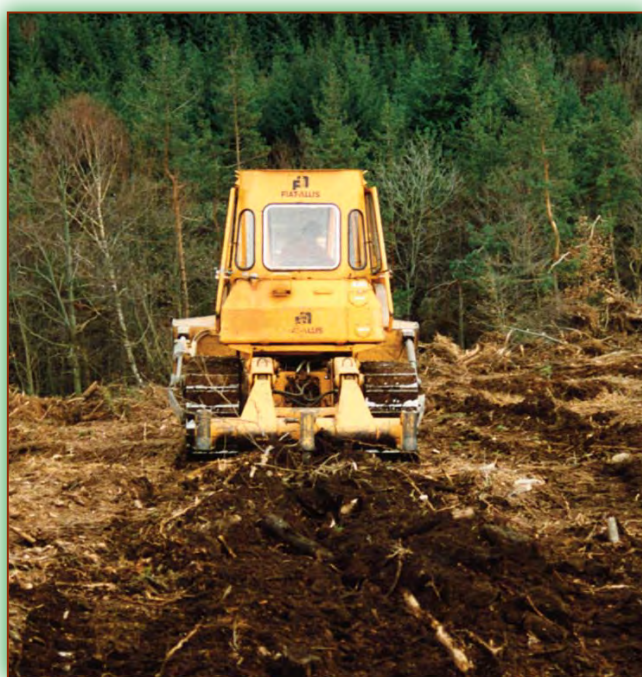
Sous-solage - DRAAF Auvergne
