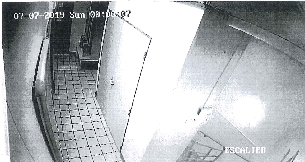
16. Vue sur le couloir du 1 er étage (accès au TGBT)
