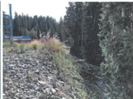
Vue du talus enroché depuis les abords de la gare de départ du TS de Séraussais
